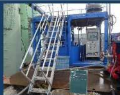
上槽への昇降階段
