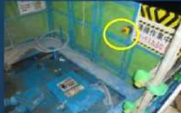
上槽ミキサー上蓋開口部付近
